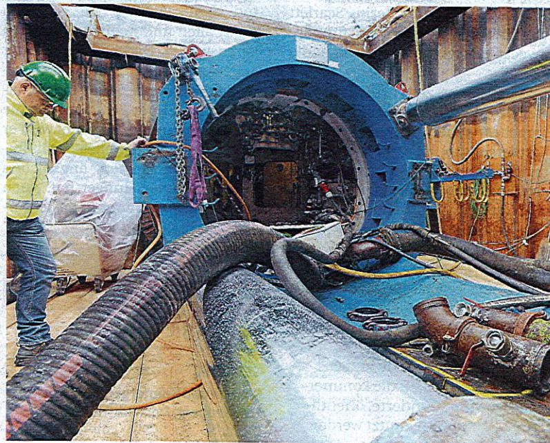
Silberfarben sind die beiden großen hydraulischen Stempel, die Stück für Stück die Bohrmaschine nach vorne schieben.
